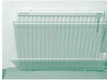
クリックが引っ掛かるまで、ブラケットの上側のパネ付タブに垂直にヒーターを引っ掛けてください。ヒーターの幅は、冷たい下降気流を避けるために窓寸法に合わせましょう。
